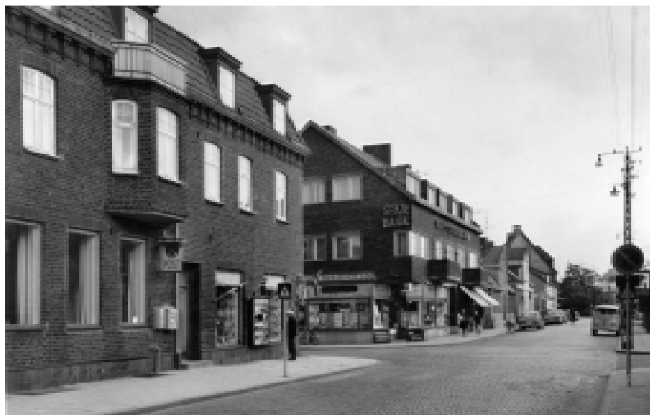
Efter ombyggnaden 1930 flyttade järnaffären in i södra delen av huset. Till husets norra del flyttade Råsås poststation.
